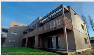
CONSTRUCTION D'UN GEDIMAT DERREY - LONGEVILLE-EN-BARROIS
