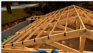
CONSTRUCTION D'UN ESAT - BRIEY
