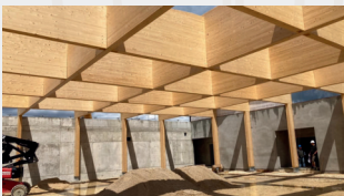
CONSTRUCTION D'UN GYMNASÉ "JEAN LAMOUR" - NANCY
