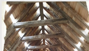
CONSTRUCTION DE LOGEMENTS - BAR-LE-DUC
