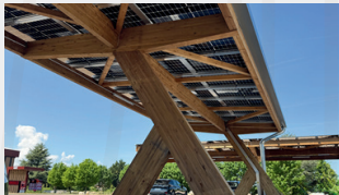
CONSTRUCTION D'UN PRÉAU ECOREPONSABLE - BAR-LE-DUC
