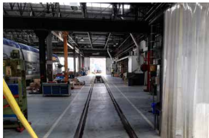
► Travaux d'aménagement intérieurs des zones de vie du bâtiment B39 du Technicentre de Metz
